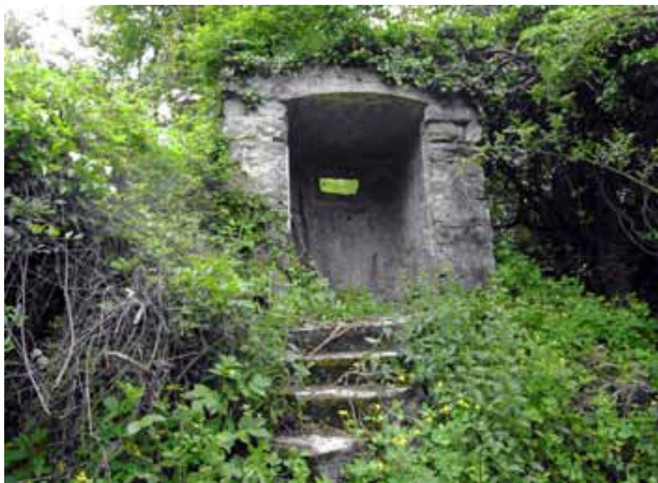
L'osservatorio prima dei lavori di recupero
