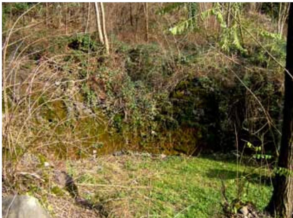
Fossa obice in località Quaresima (Condino)
